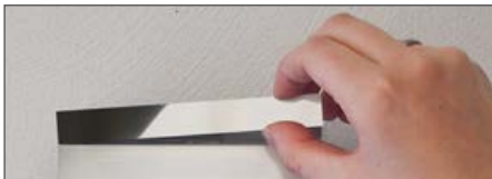
2 Edelstahlstreifen entfernen (nur bei Serie 10)
