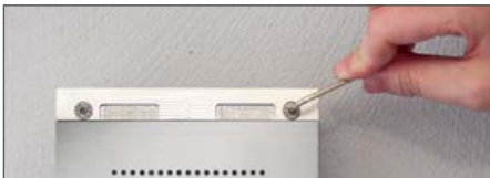
3 Türstation anschließen und im vorgesehen AP/UP-Gehäuse, Hohlwand oder in der Behnke-säule (nur Serie 5) befestigen. Bei Geräten der Serie 10 die Edelstahlstreifen wieder befestigen.
