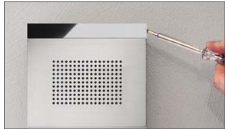
1 Edelstahlstreifen abklipsen
