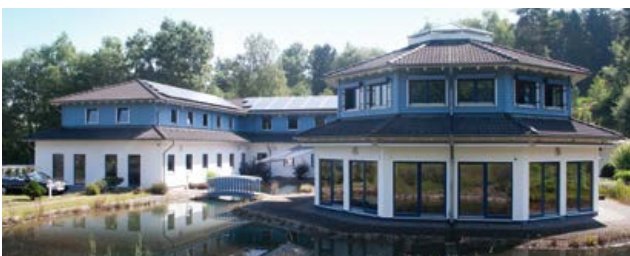
Firmengebäude in Kirkel
